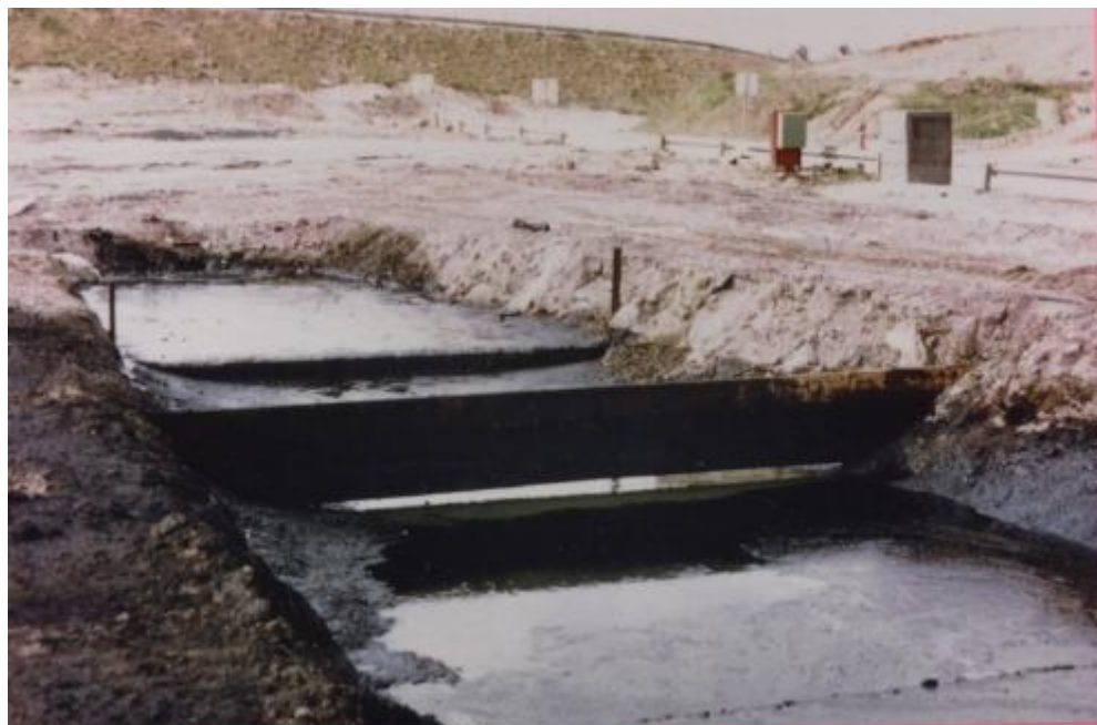
Annahmebecken für Ölschlämme
