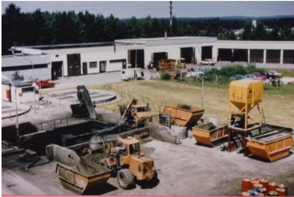
Annahmebecken für Ölschlämme
