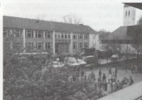
Abb. I – 8.2/19b: Ruhr Laufende Durchsagen zur Information der Betroffenen (Rundfunk, mobile und stationäre Lautsprecher). Da die Bundespost das einzige Anlauftelefon des Notarztes nicht reparieren konnte, mußte der technische ABC-Zug (erfolgreich) aus- helfen.
